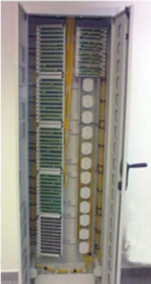
El repartidor óptico Cofitel ETSI HD es un repartidor de planta interna diseñado para terminar una alta densidad de fibras pudiendo llegar en su totalidad hasta 1320 F.O. en un único armario o bastidor, y diferenciado este por módulos individuales de hasta 132 F.O. con terminación en formato SC, con diferentes posibilidades de acabados según las necesidades, pues podemos incluir módulos de splitters y módulos para almacenaje de F.O.
