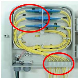
Una vez conectados los Pig Tails externos a los acopladores, darles salida a través de los orificios previstos en la base de la caja
