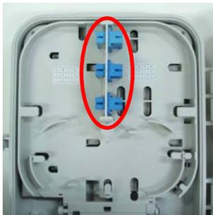
Montaje de los acopladores hembra - hembra
