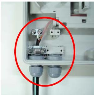
Introduzca el cable en los prensaestopas y fije el elemento de resistencia con los tornillos previstos al efecto
