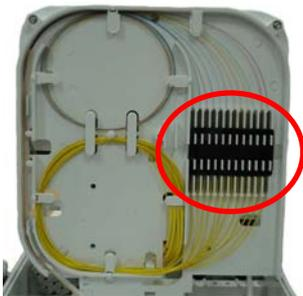
Secuencia de fijación de los empalmes a la fibra óptica del cable
