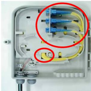
Una vez conectados los Pig Tails a los acopladores, el cable debe pasar a la parte posterior de la placa
