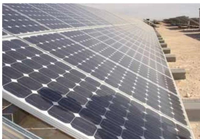
Instalación solar con paneles fijos
