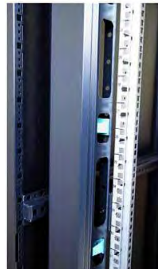
Vista del canal con la tapa montada y las aberturas de cableado de gran capacidad, que confieren al conjunto una imagen elegante.
