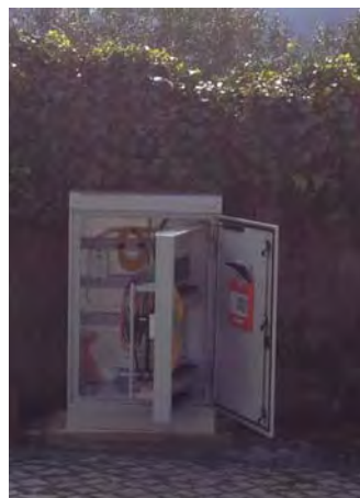
Armarios para exterior con bastidor basculante
