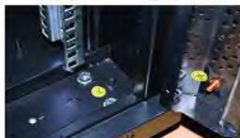
Tomos de tierra en todas las piezas del armario con etiquetas normalizadas.
