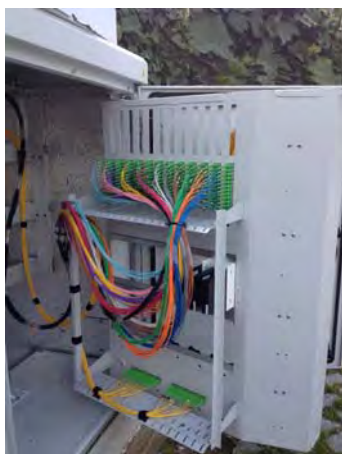
Armarios para exterior con bastidor basculante
