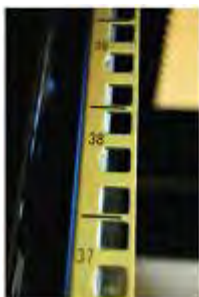
Unidades rack numeradas en todos los perfiles.
