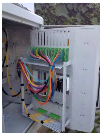
Armarios para exterior con bastidor basculante
