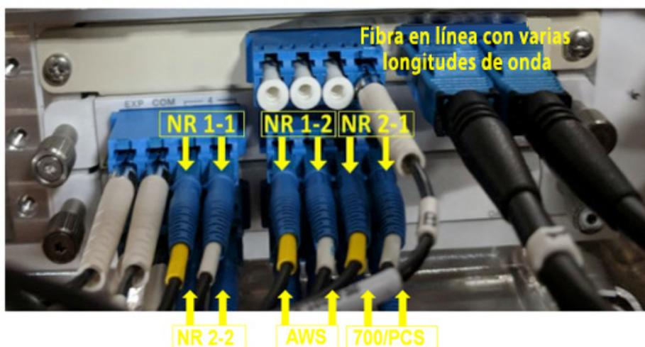
Figura 11. Fibra óptica con diversas longitudes de onda en una sola fibra que se divide en numerosas longitudes de onda que se dirigen a distintos radios
