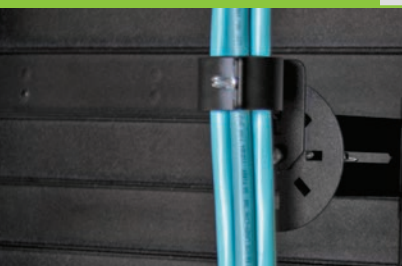
KIT de sujeción universal de montaje en rack instalado
