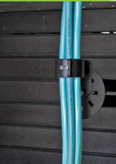
Kit de sujeción universal de montaje en rack instalado
