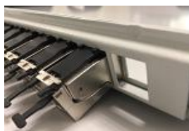
Panel frontal con capacidad para 8 módulos UTP/FTP
